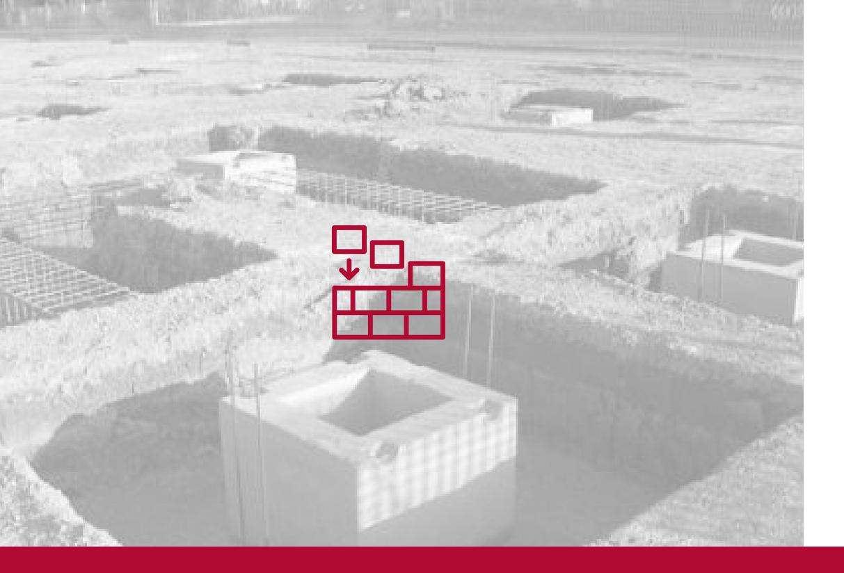
I fabbricati sorgeranno su idonee fondazioni, del tipo su **pali** e **plinti**, realizzate mediante getto in opera di calcestruzzo armato di adeguate caratteristiche e delle dimensioni risultanti dai calcoli statici, tale da sollecitare il terreno in relazione alla propria natura.
