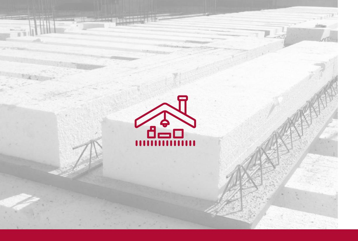
Saranno di tipo **Predalles** per il primo solaio secondo la normativa antincendio e del tipo **misto** in **c.a**. e **laterizio** per tutti gli altri, dello spessore minimo cm. 20+6 ed armatura metallica calcolata per sovraccarichi permanenti pari a da N 250 ogni mq, sia per quelli che riguardano le unità immobiliari destinate a residenza e per le sole superfici al piano terra destinate a locali accessori.
