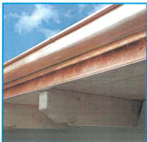
Dovranno essere eseguite tutte le necessarie lattonerie realizzate con lastre di rame spessore di 8/10 mm con le caratteristiche previste dal progetto e dai particolari costruttivi.
