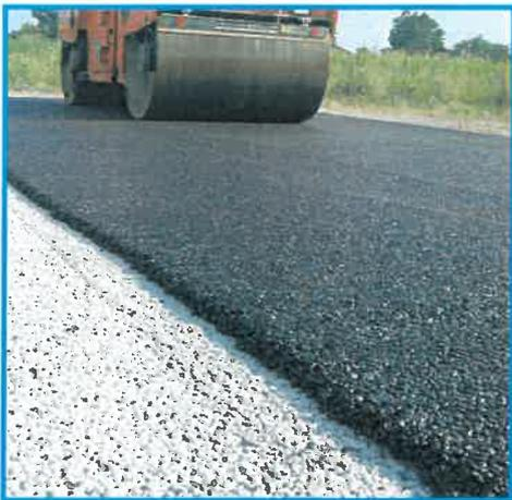
L'Appaltatore dovrà eseguire tutti i ripristini delle massicciate e delle pavimentazioni stradali interessate dai lavori di costruzione dei fabbricati, e dai relativi allacciamenti ai pubblici servizi. Dovrà essere previsto un ripristino provvisorio dei tappeti bituminosi seguito dal ripristino definitivo dei tappeti bituminosi e del tappetino d'usura dell'asfalto.
