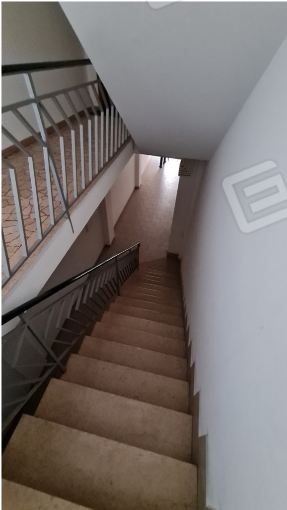
Vano scala comune
