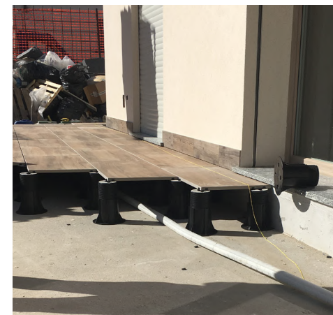
Pavimentazione marciapiede e giardini privati: galleggiante
