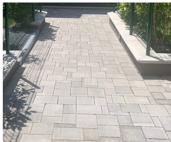
Pavimentazione cortile condominiale: autobloccante
