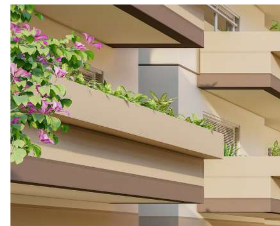
Fioriere gettate in opera, integrate nel parapetto del balcone
