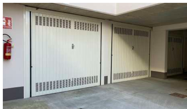
BASCULANTI IN FERRO zincate e verniciate
