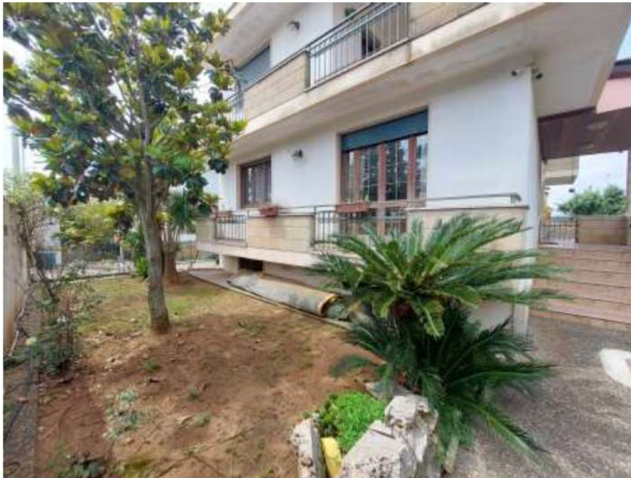
Foto 5 – dall'esterno del prospetto ovest
