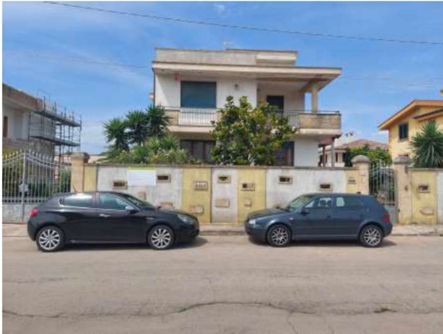
Foto 1 – prospetto su via Caserta
