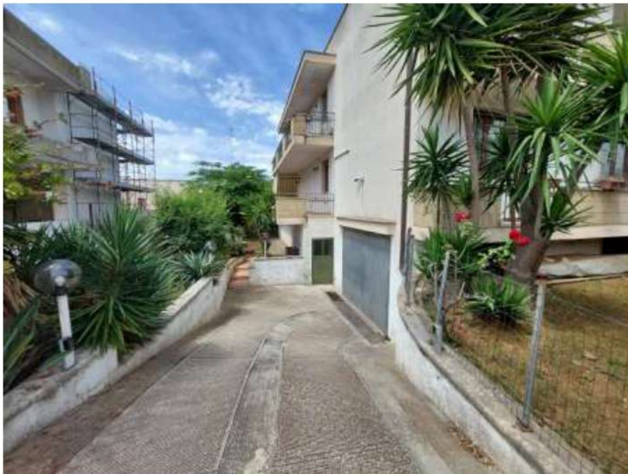
Foto 15 – rampa e prospetto garage di copertura.
