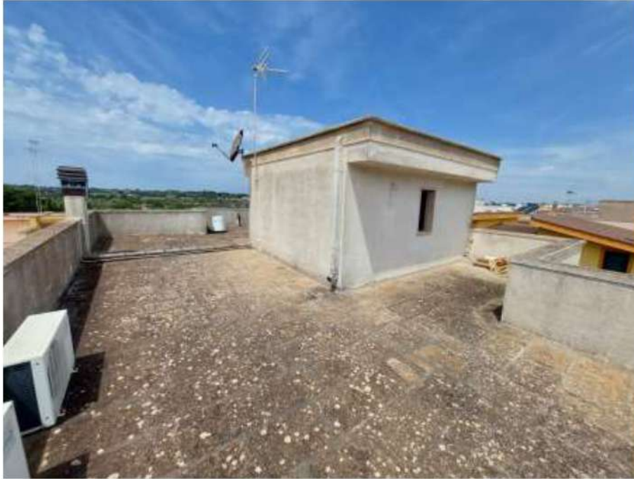
Foto 14 – terrazza di copertura.
