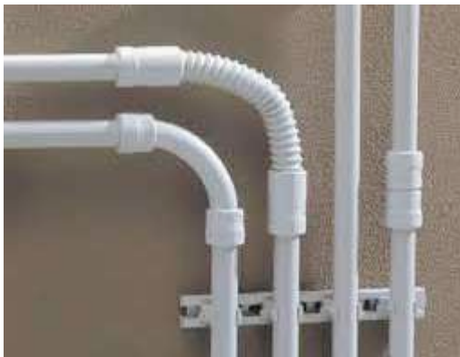
(Distribuzione a vista e Serie civile Bticino Matix in contenitore Idrobox)
