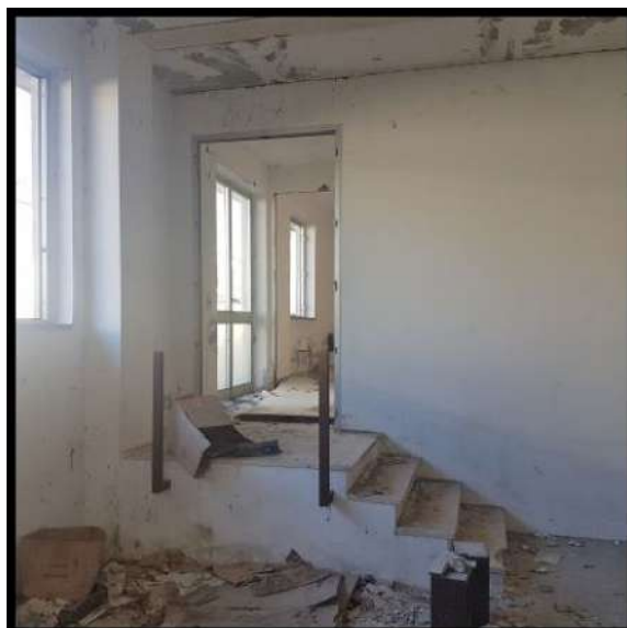
Foto 12 Interno ingresso altri uffici.JPG
