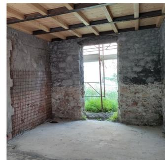
Art.5 **Demolizione dell'attuale struttura del tetto** in travi e travicelli di legno, compreso puntellature se necessarie, scempiatura di mezzane di cotto e copertura in embrici e canaletti, compreso lo stoccaggio a terra per lo smaltimento.
