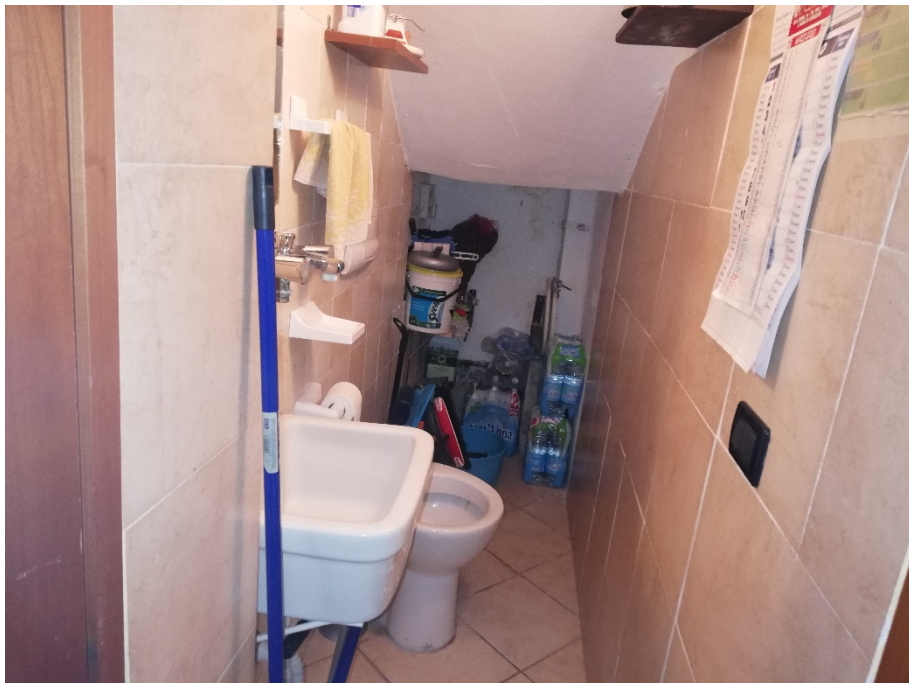
Bagno di servizio ubicato nel sottoscala
