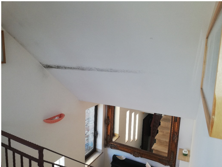
Soffitto del vano scala
