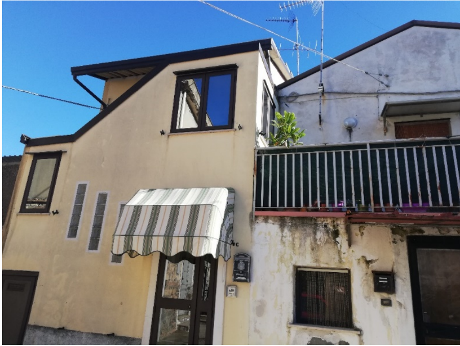
Prospetto Ovest – portoncino di accesso
