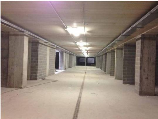
Il pavimento di tutti i piani interrati sarà in calcestruzzo vibrato e lisciato, finito con spolvero di quarzo miscelato con cemento.
