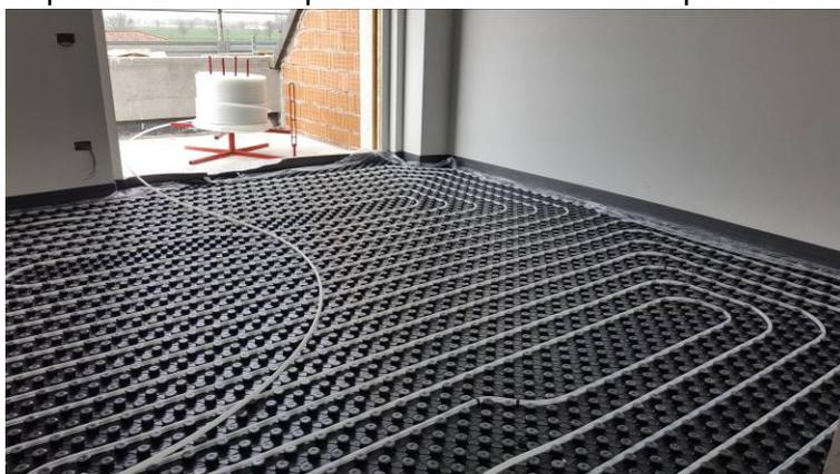
La termoregolazione sarà effettuata in ogni alloggio mediante termostato ambiente in ogni locale dell'alloggio collegato elettricamente al collettore con elettrovalvole ed installato secondo le prescrizioni della Casa Costruttrice.
