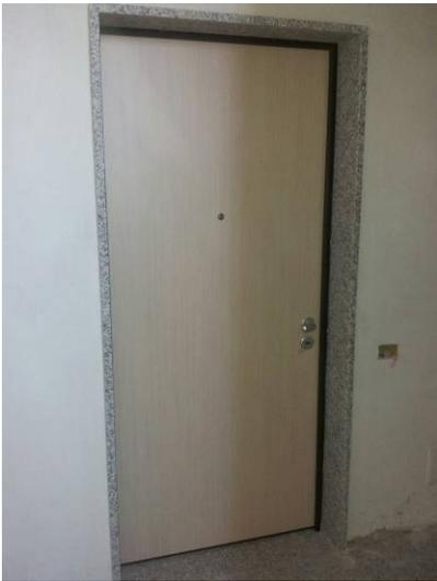
Le porte interne saranno ad anta di tipo tamburato pieno con ossatura perimetrale in essenza. Riempimento della struttura con alveolare semiresinato maglia 20 mm; copertura con pannelli in laminato, rivestiti da impiallacciatura in noce tanganica tinto, bianco, frassino o vengè, previa calibratura del tamburato, spessore complessivo 40 mm..
