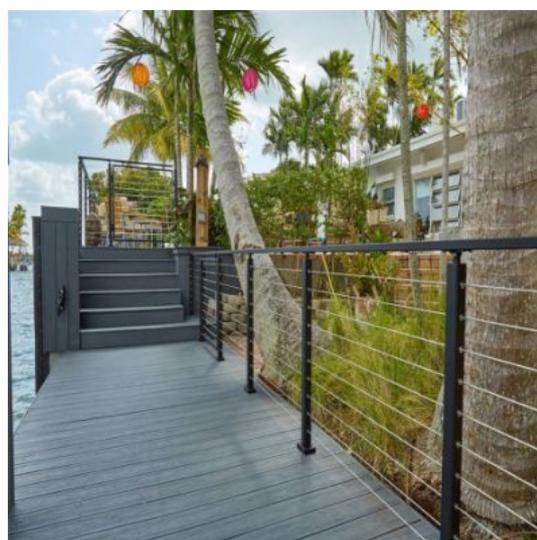
I parapetti esterni saranno realizzati con struttura in acciaio verticale verniciati e cavi in acciaio orizzontali equidistanti. Il corrimano sarà realizzato con profilato rettangolare in acciaio verniciato.
