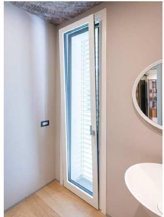
Le finestre e porte finestre e gli alzanti scorrevoli, saranno dotati esternamente di tapparelle d'oscuro in alluminio coibentato complete di ferramenta per movimentazione, guide in alluminio con spazzolino e motorizzazione con apparecchi completi di attacchi e adattatori.
