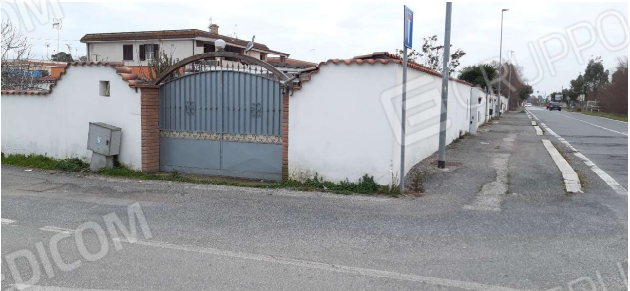
4 – Vista proprietà via Manta angolo via Geminiano Montanari
