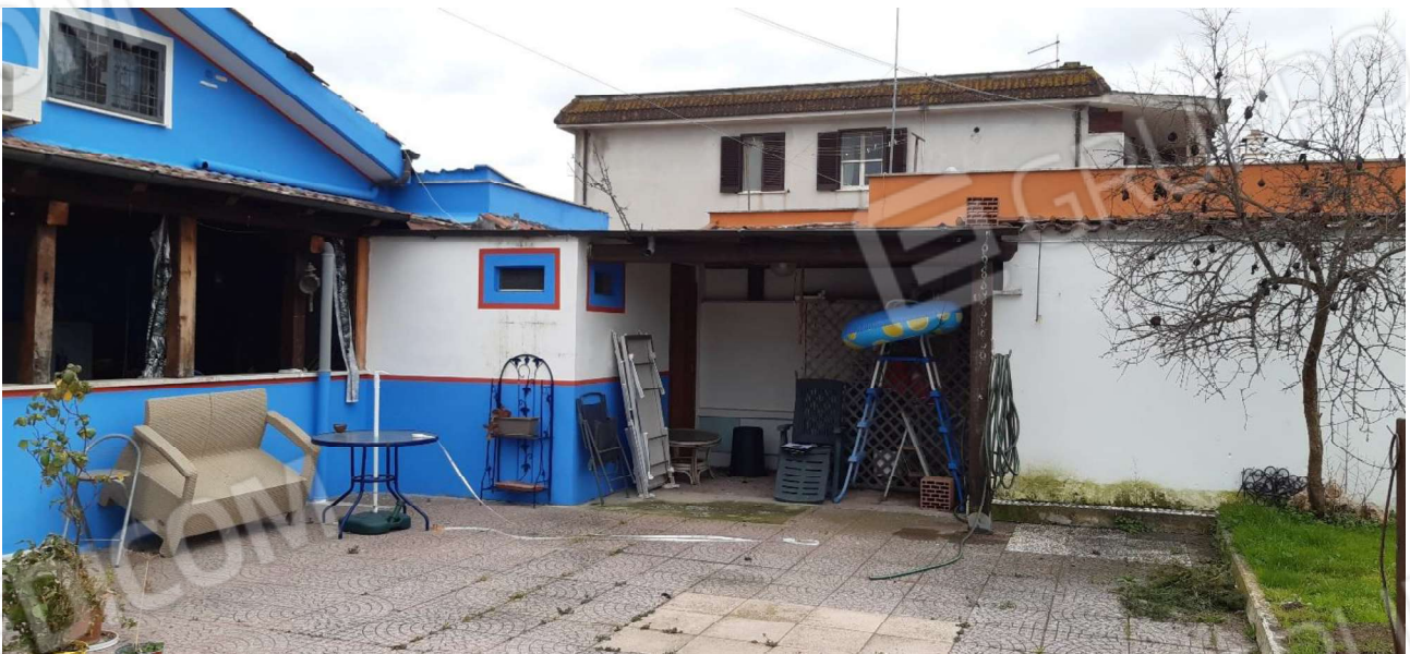
30 – vista portico laterale con deposito esterno
