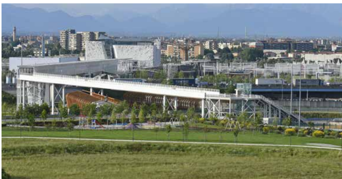
LA PASSERELLA Installata durante Expo 2015, sorvola autostrada e ferrovia e collega MIND e UpTown
