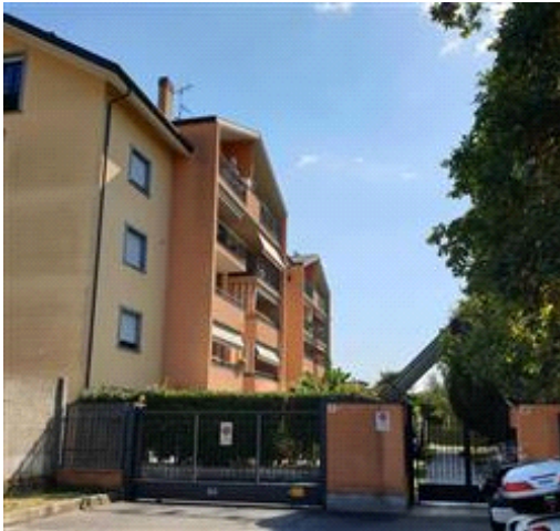
palazzi visti dall'accesso pedonale e carrabile
