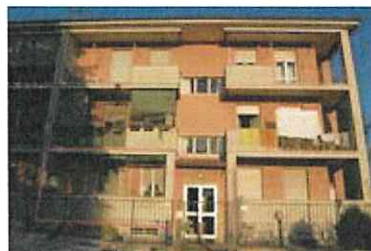
Facciata principale - ingresso
