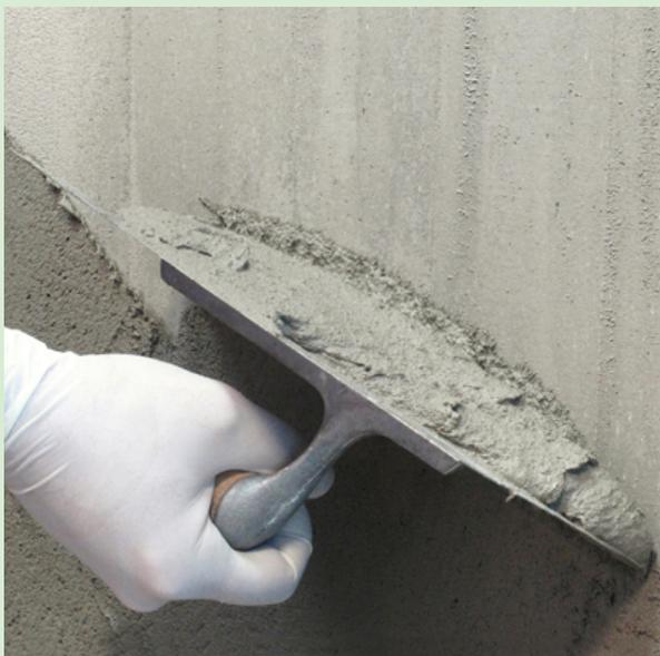
Intonaco interno eseguito con uno strato di malta cementizia pronta all'uso ed uno strato di stucco bianco liscio.
