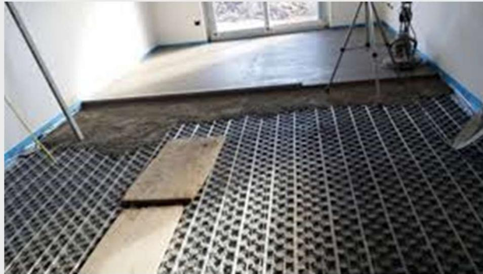
*Figura 10 – esecuzione massetto radiante*
