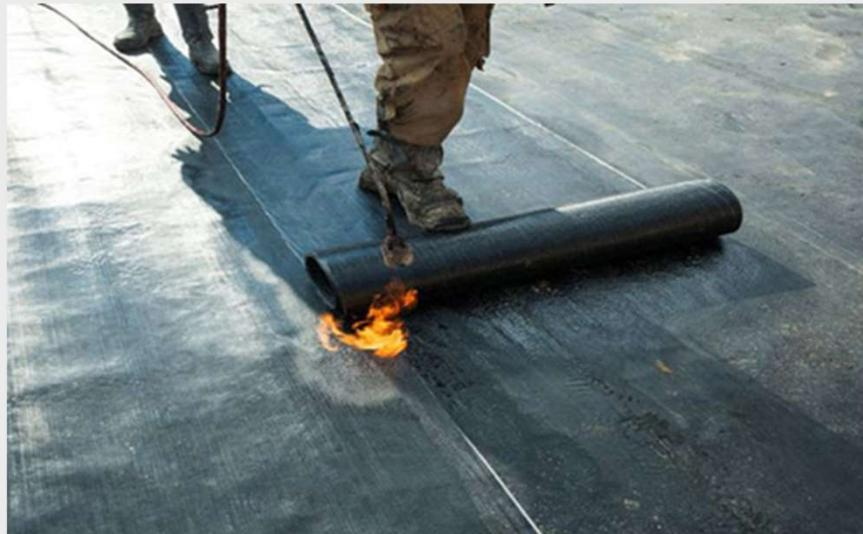
*Figura 2 - impermeabilizzazione di tenuta con guaina applicata a fiamma*
