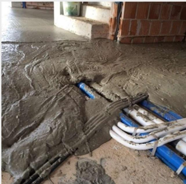
*Fig.9 – Esecuzione sottofondo alleggerito*
