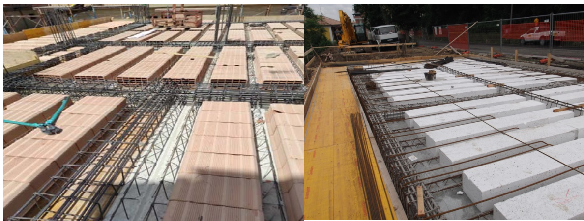
Figura 3 - Esempio struttura solai
