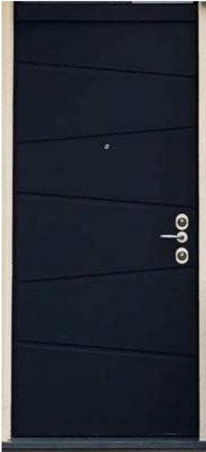
Le porte di accesso agli alloggi sono realizzate con profili di alluminio, in coerenza con i serramenti e serratura di sicurezza. (la foto allegata è puramente indicativa, colore e finitura sarà a scelta della D.L.)
