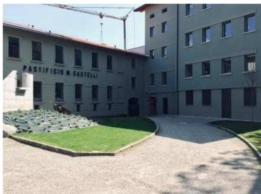
Le pavimentazioni esterne comuni saranno realizzate in **calcestre** e saranno delimitate da cordonatura costituita da elementi in cemento. La pavimentazione sarà dotata di pozzetti con grigliati in ghisa e di canalette componibili grigliate carrabili posizionate in quantità sufficiente a garantire il deflusso delle acque meteoriche.
