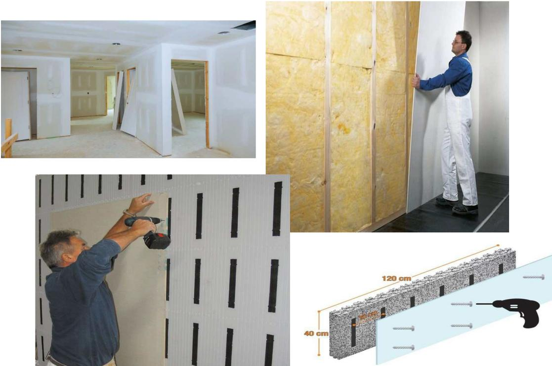
Le pareti perimetrali in Climablok all'interno dell'abitazione verranno, dopo aver predisposto gli impianti tecnologici, rivestite in cartongesso doppia lastra, completate con l'applicazione di due mani di stucco con rete dove necessario, pronte ad essere tinteggiate.
