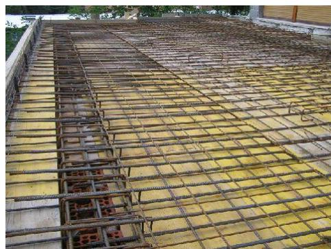
Scale, pianerottoli e vani ascensore in calcestruzzo di cemento confezionato a macchina con classe di resistenza C25/30 gettato in opera e opportunamente vibrato, con armatura metallica in acciaio B450C ad aderenza migliorata nelle quantità come da calcoli statici.
