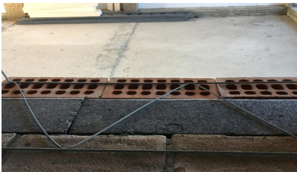
LEGATURA DELLE MURATURE CON RETE con apposita rete murfort
