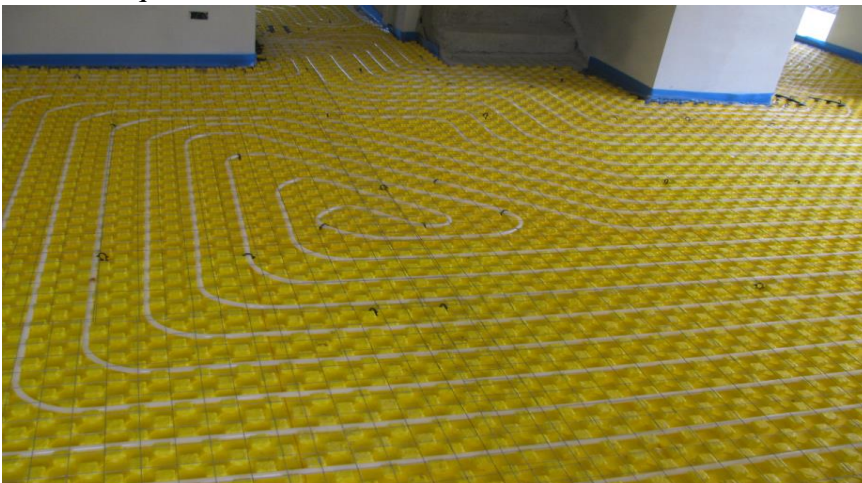
RISCALDAMENTO A PAVIMENTO
