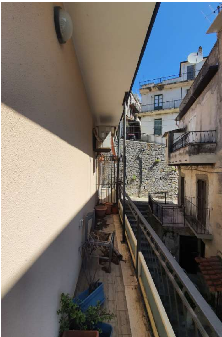
Figura 14 - Balcone lato est
