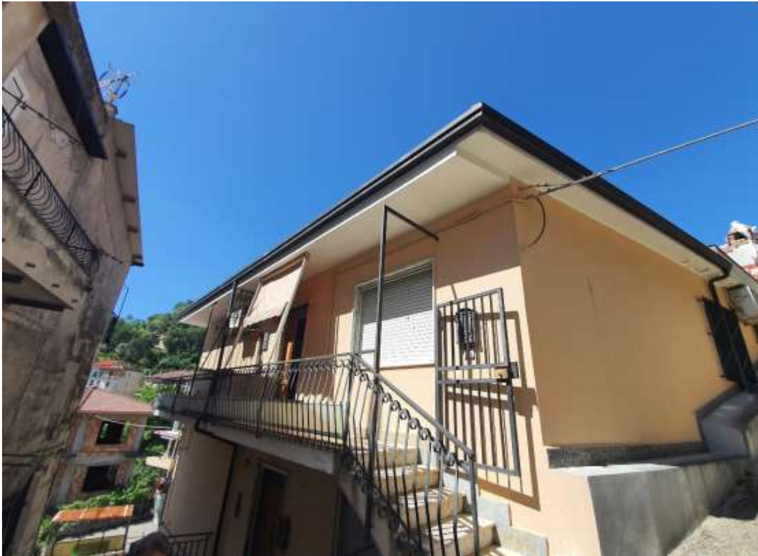
Figura 3 - Vista prospettica dell'immobile dal lato est
