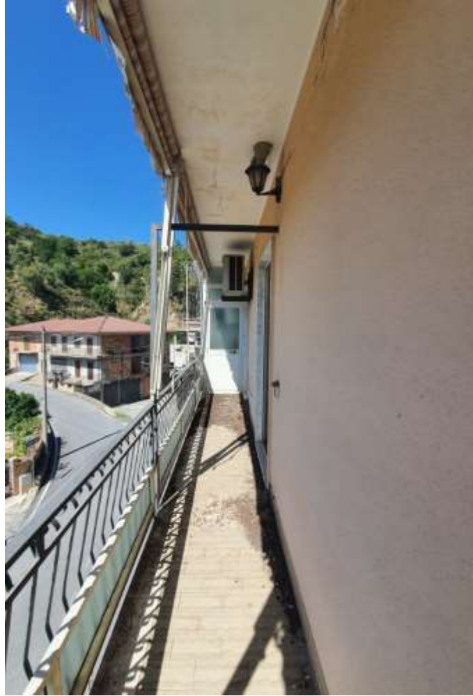
Figura 13 - Balcone lato sud
