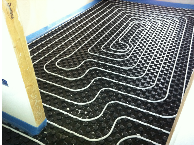
Riscaldamento a pavimento posato
