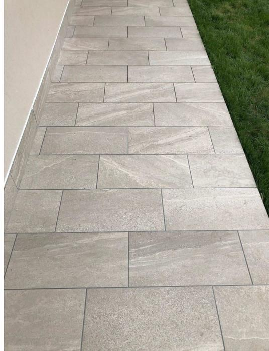
57. Realizzazione di **pavimento delle terrazze, logge e poggioli**, mediante la fornitura di pavimento sopraelevato costituito in gres porcellanato antigelivo e antisdrucciolo, formato 60x60 cm., 40x60 cm. o altro formato minore, disponibile in commercio. Colore e serie a scelta della D.L.. I pavimenti saranno posati sopra a dei supporti. Battiscopa in lamiera preverniciata.
