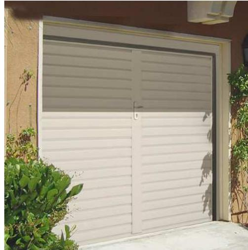
50. Fornitura e posa in opera di **porte di chiusura della nicchia contatori** in alluminio a protezione per i contatori dell'energia elettrica (se esterno), posizione e dimensione previo accordo con le rispettive aziende; nel caso i contatori dell'energia elettrica vengano richiesti all'interno del fabbricato, si realizzerà un armadio in alluminio di protezione.
