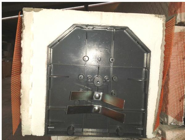
46. **Fornitura e posa di persiane avvolgibili a rullo motorizzate**, realizzati con profili in alluminio coibentati con poliuretano espanso ad alta densità ecologico per migliorare l'insonorizzazione e l'isolamento termico, fornite e poste in opera, compreso ogni onere per il corretto funzionamento con apertura – chiusura elettrica co dispositivo a uomo presente; le guide fisse in acciaio zincato a U, colore RAL standard a scelta della D.L..
