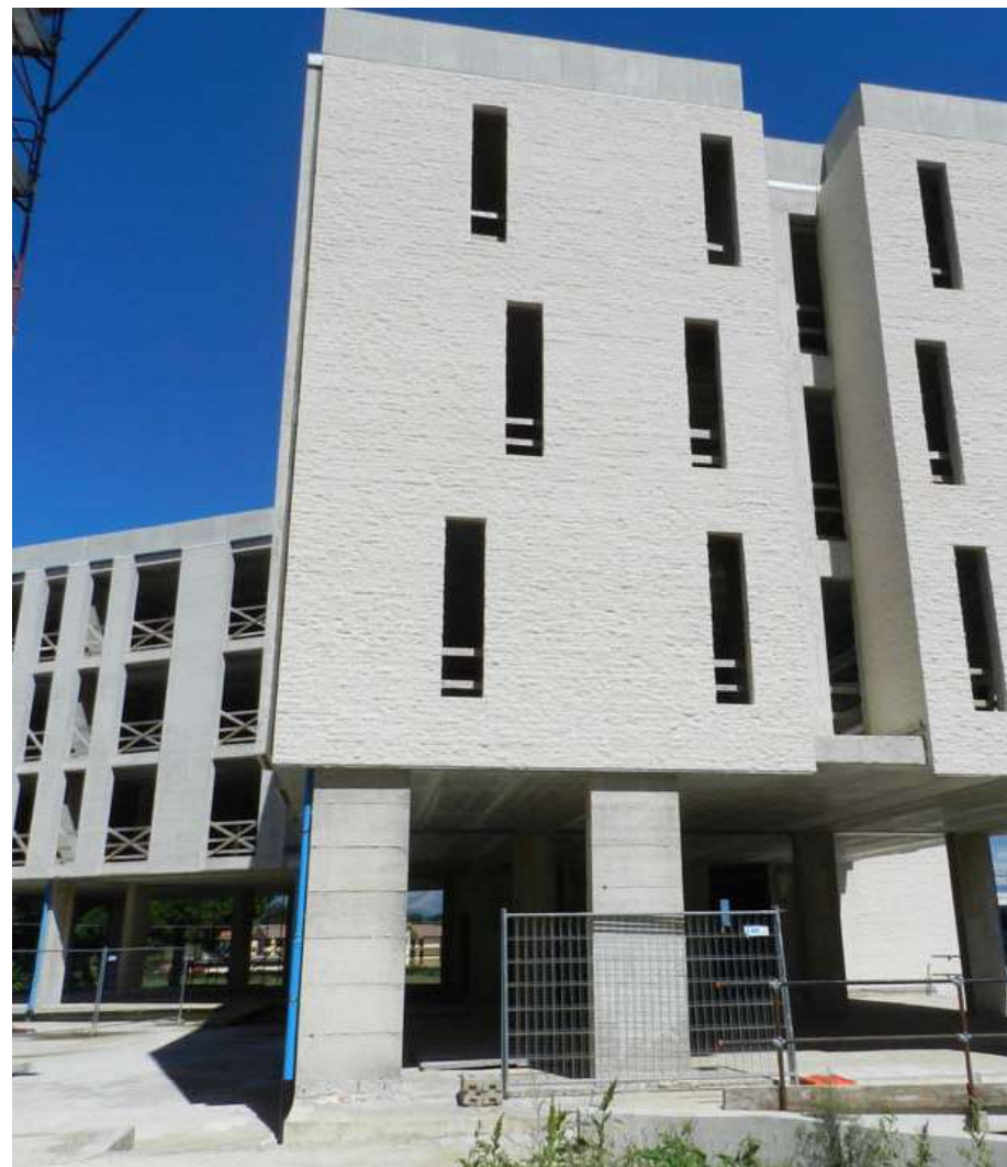
vista del prospetto laterale della struttura
