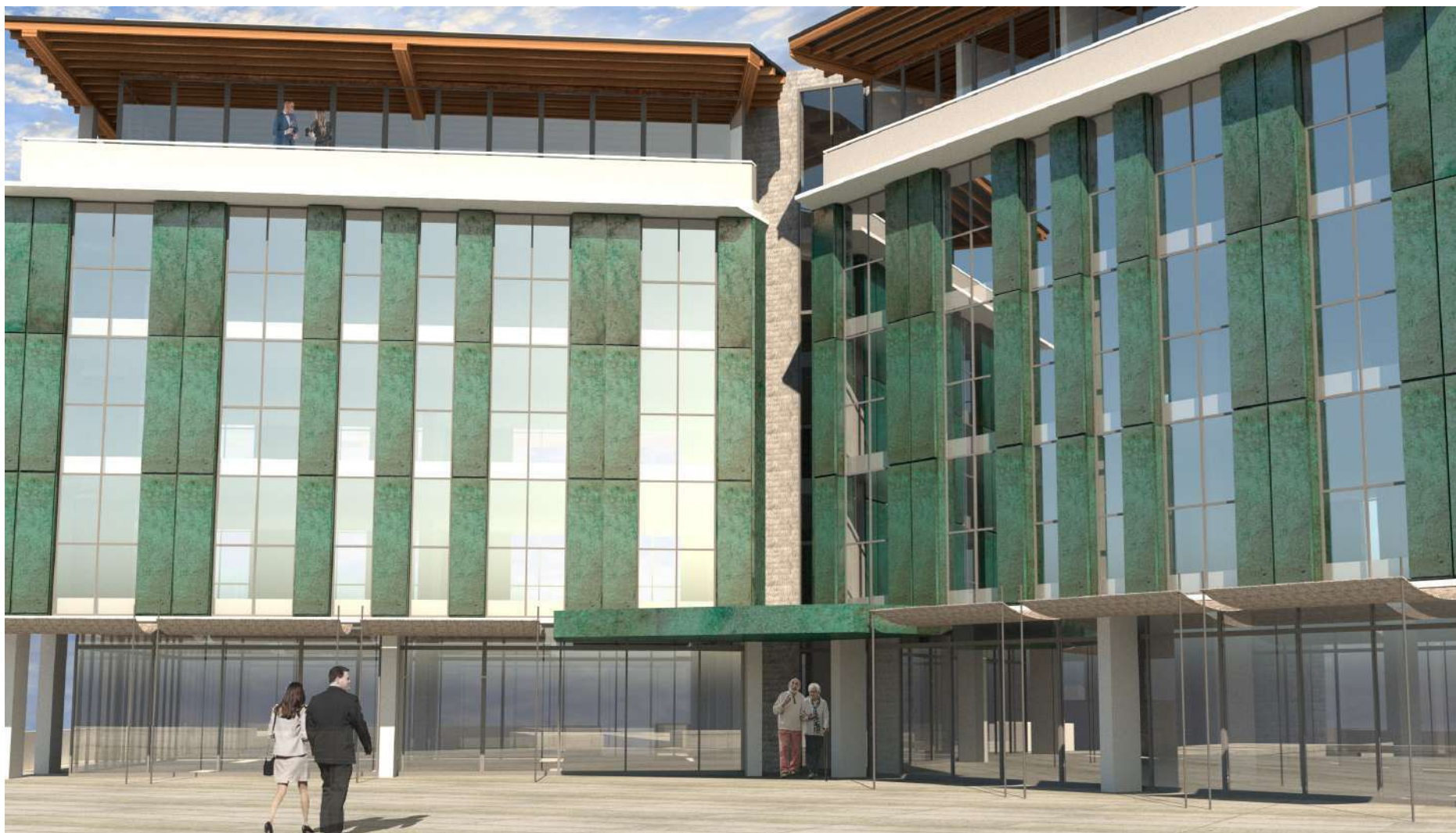
vista della facciata principale
