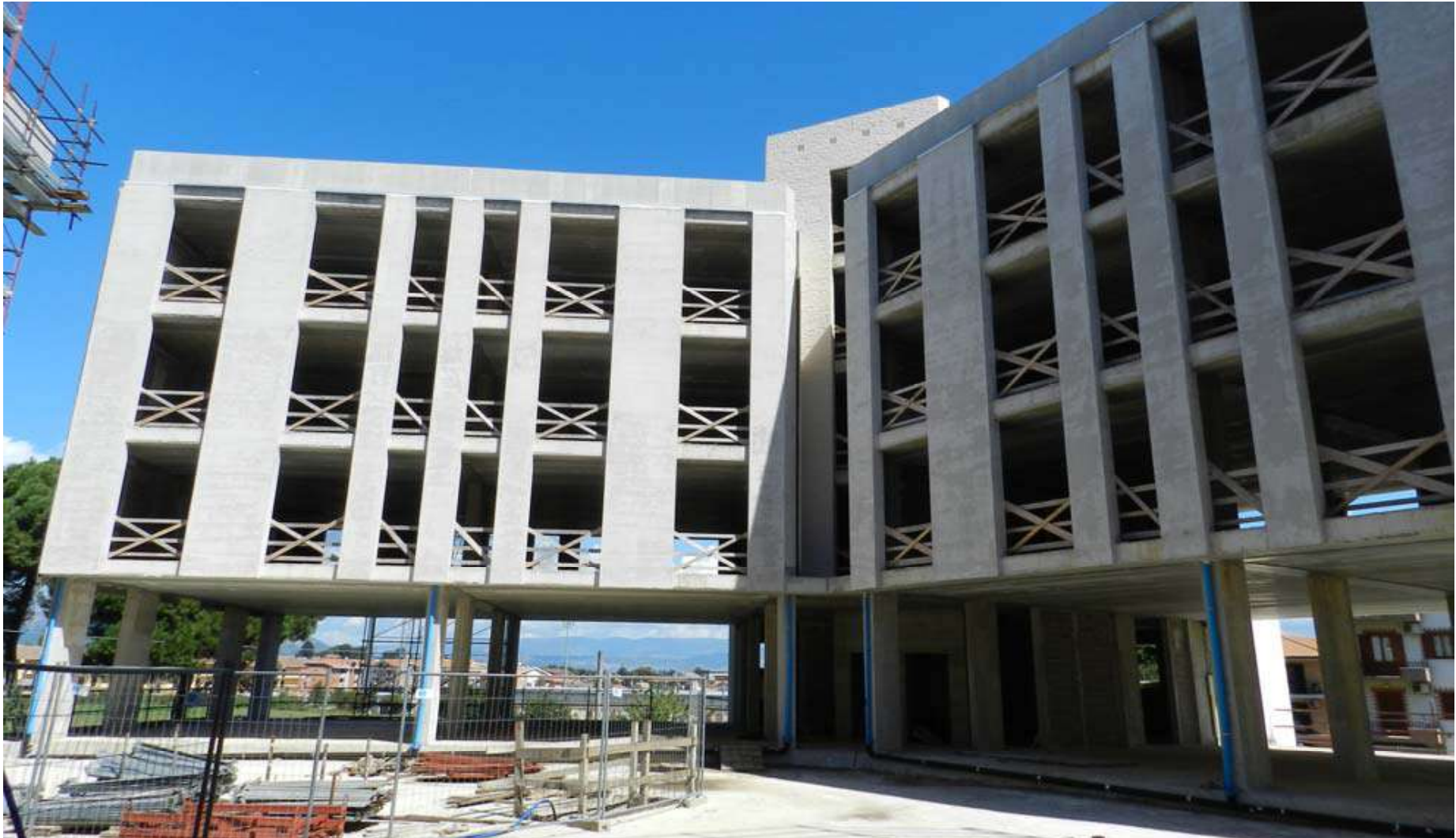
vista della facciata principale
