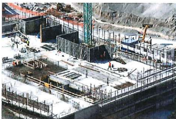
1, 2 Strutture e solette in calcestruzzo armato
