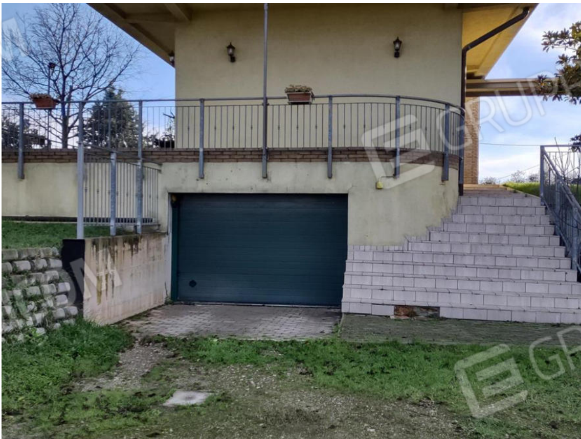
FOTO 48. albergo P. - 1: portone di accesso al garage
