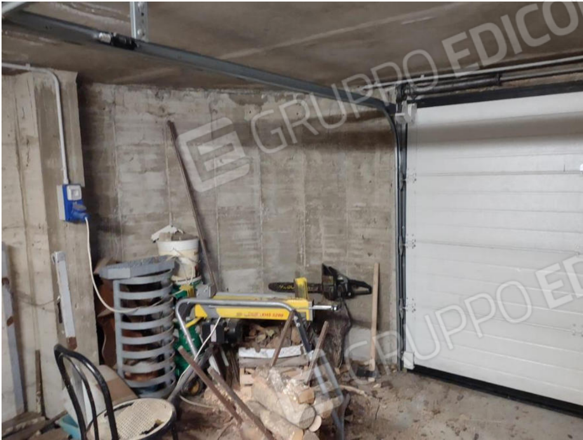
FOTO 49. albergo P. - 1: interno del garage
