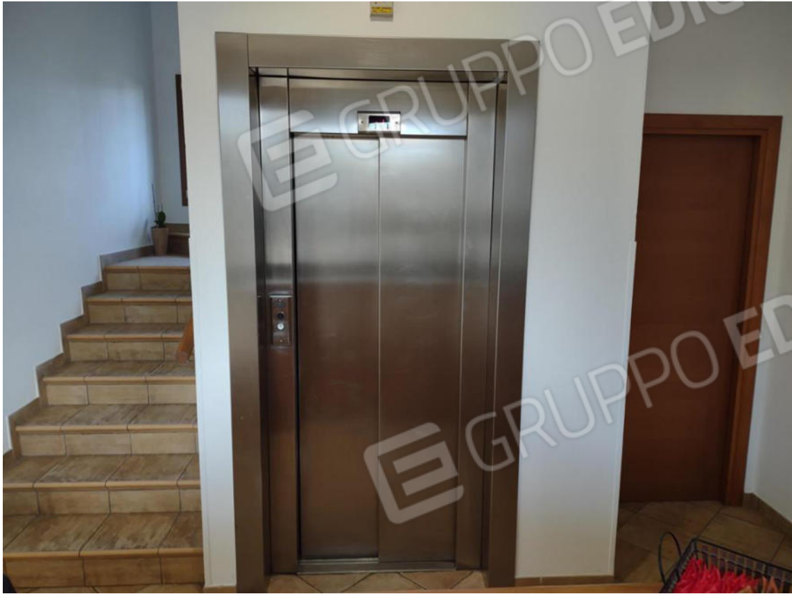
FOTO 25 - 26. albergo P. T: il vano scale e l'ascensore
