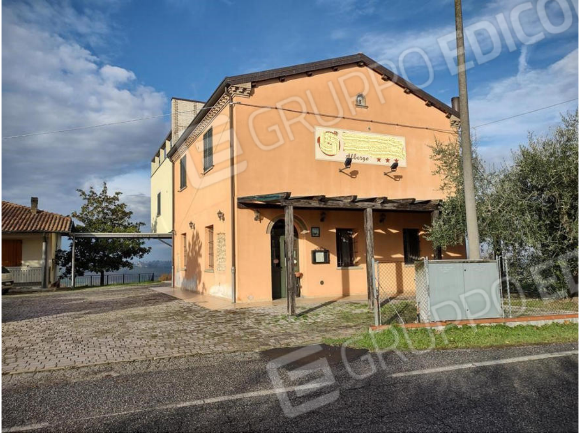
FOTO 1. Fronte del fabbricato su Via Consolare
