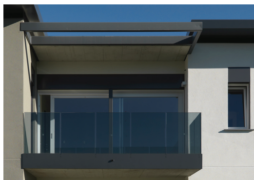
B1 - g _ Balconi con parapetti in vetro
