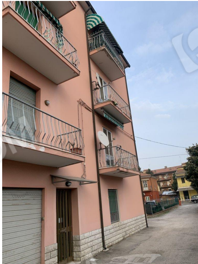
Foto 2: Prospetto fronte strada – porzione abitazione
