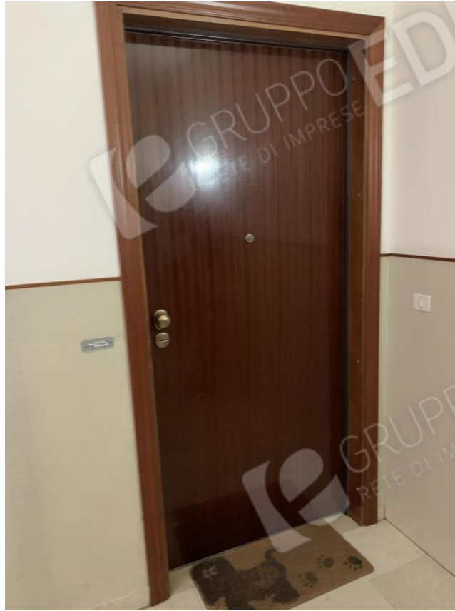
Foto 11: Portoncino di ingresso
