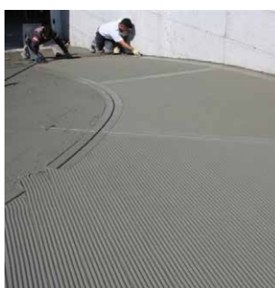
D1 - d _ Rampa corsello
