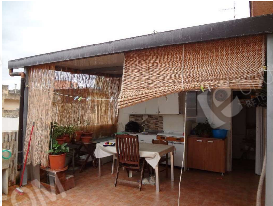
Terrazzo piano secondo struttura precaria
