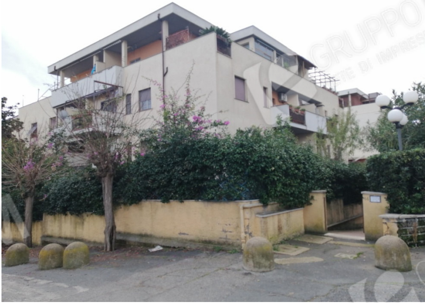
VEDUTA DEL FABBRICATO B DA VIA DELLE DALIE.
