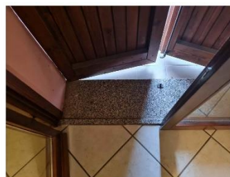
FOTO 30 - DETTAGLIO PAVIMENTO, SOGLIA, INFISSO E SCURONI
