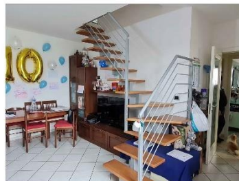
FOTO 32 - SCALA SOTTOTETTO DIFFORME
