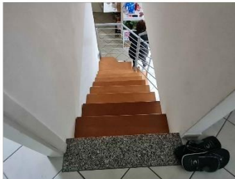
FOTO 56 - MATERIALI SCALA SOTTOTETTO
