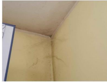
FOTO 65 - UMIDITA', CONDENZA E MUFFA NELLE MURATURE ESTERNE
