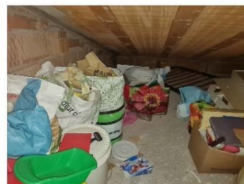
FOTO 42 - RIPOSTIGLIO GREZZO SOTTOTETTO
