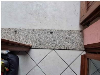
FOTO 55 - DETTAGLIO PAVIMENTI E SOGLIA
