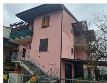
FOTO 03 - VISTA DA VIA MAZZINI
