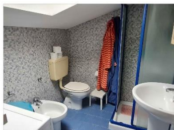
FOTO 40 - BAGNO SOTTOTETTO DIFFORME
