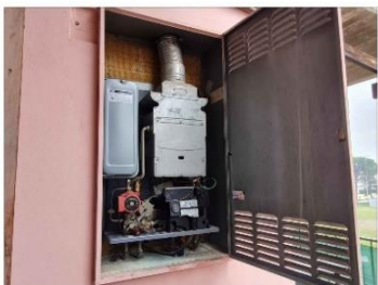
FOTO 46 - CALDAIA BERETTA
