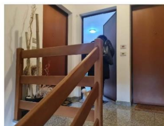
FOTO 24 - PARAPETTO SCALA CONDOMINIALE
