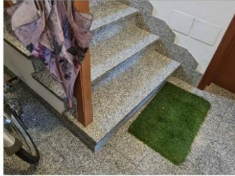
FOTO 58 - PAVIMENTI AREE CONDOMINIALI
