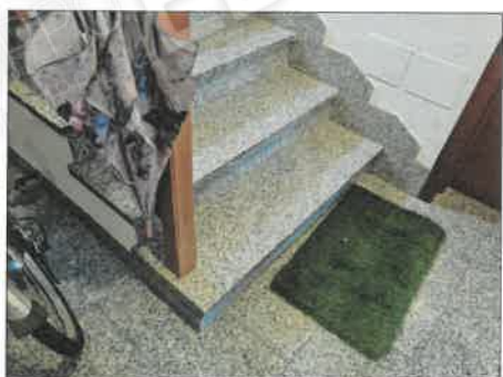
FOTO 58 - PAVIMENTI AREE CONDOMINIALI
