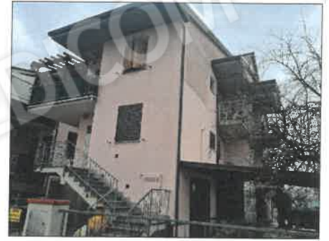
FOTO 03 - VISTA DA VIA MAZZINI
