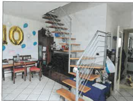
FOTO 32 - SCALA SOTTOTETTO DIFFORME
