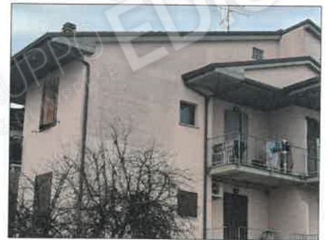
FOTO 06 - VISTA DEL TERRAZZO DELLA ZONA NOTTE
