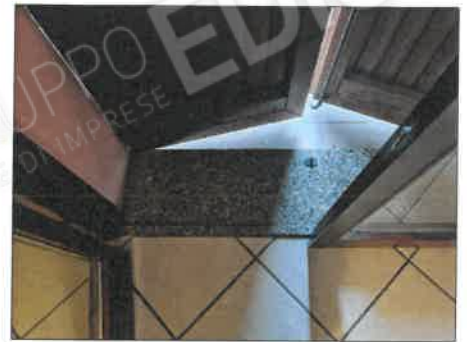
FOTO 30 - DETTAGLIO PAVIMENTO, SOGLIA, INFISSO E SCURONI
