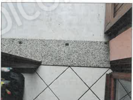
FOTO 55 - DETTAGLIO PAVIMENTI E SOGLIA
