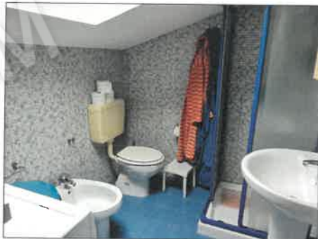
FOTO 40 - BAGNO SOTTOTETTO DIFFORME
