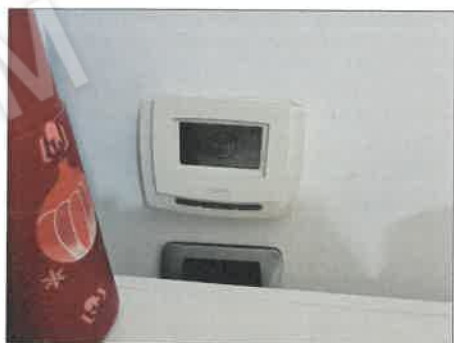
FOTO 52 - CRONOTERMOSTATO
