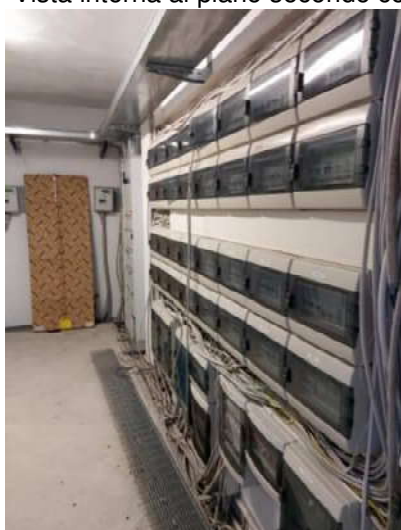
Vista interna al p. terra locale contatori e appositi cassonetti contatori acqua dietro centrale termica comune
