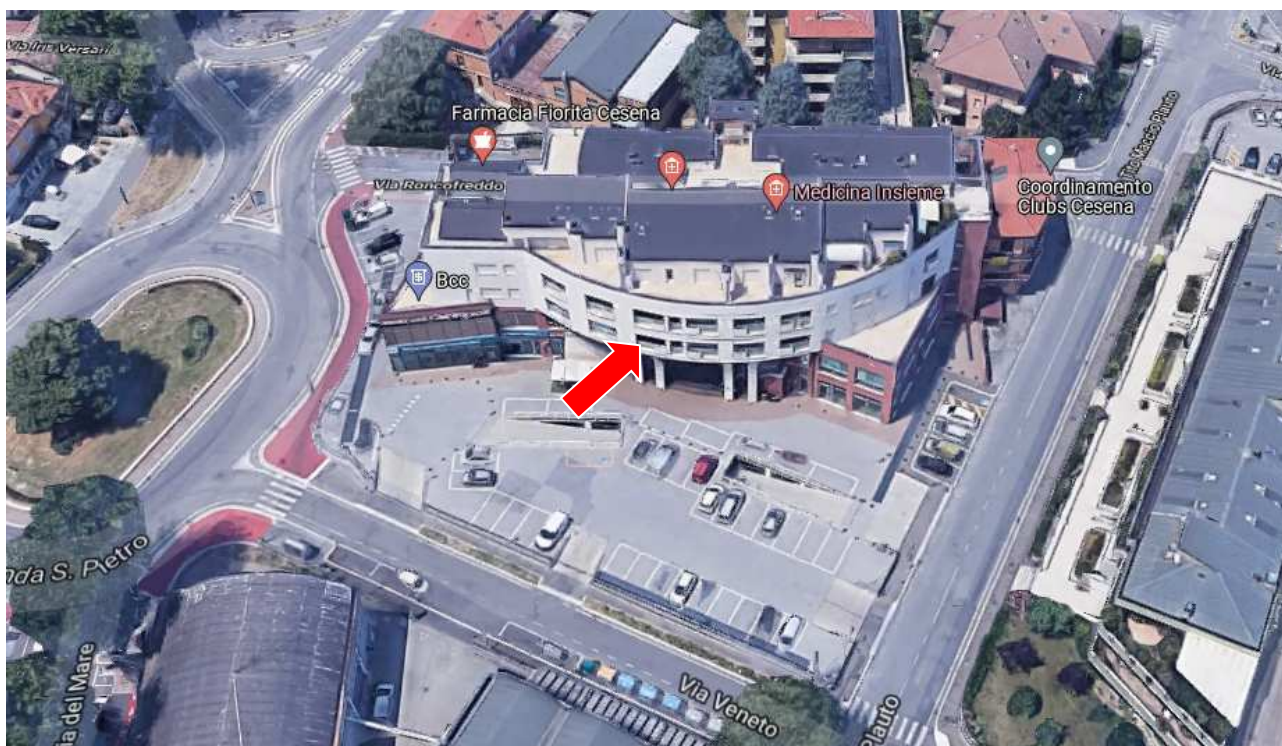
Vista complesso condominiale via veneto con individuata la localizzazione dell'unità ufficio
