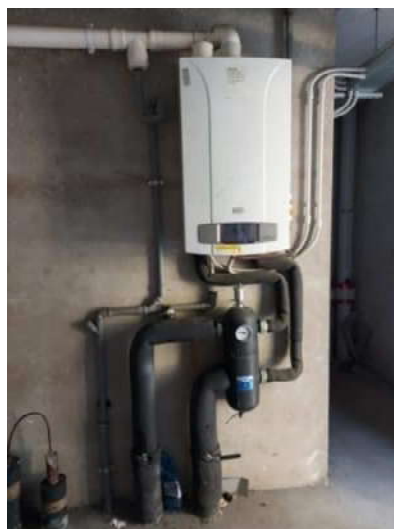
Vista esterna piano terra centrale termica comune e vista interna caldadia gas metano esclusiva del Sub 168
