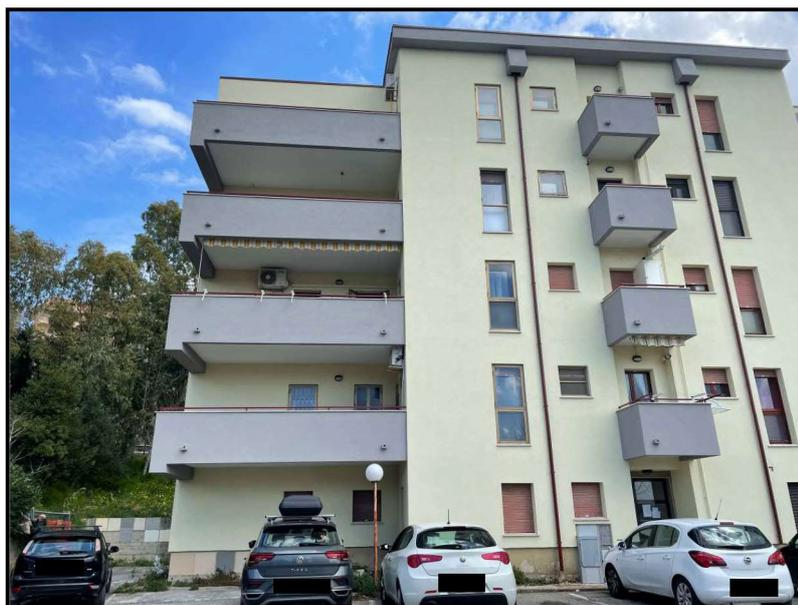
La struttura dell'edificio è in cemento armato con tamponature esterne in laterizio ed isolamento termico esterno a cappotto, realizzato a seguito di un recente intervento di manutenzione straordinaria delle facciate.
