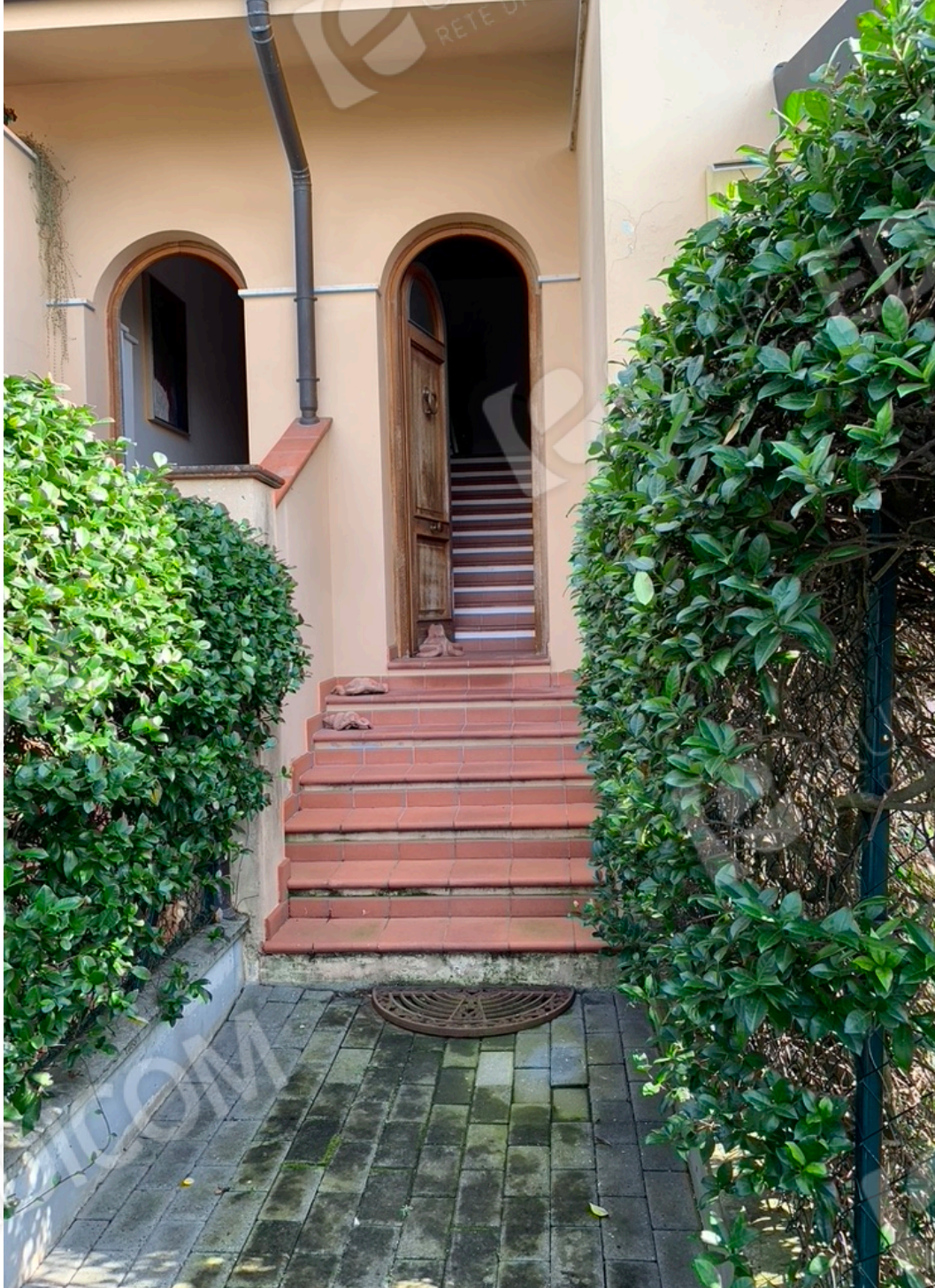
FOTO E5 fabbricato, fronte principale, ingresso immobile lato NORD-OVEST
