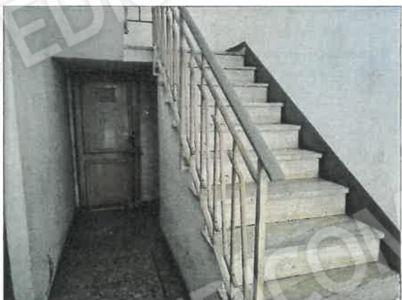
FOTO 7 - SCALA PALAZZO VISTA PORTA CORTILE INTERNO
