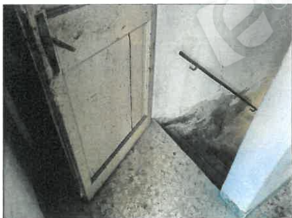
FOTO 8 - VISTA PORTA PIANO INTERRATO
