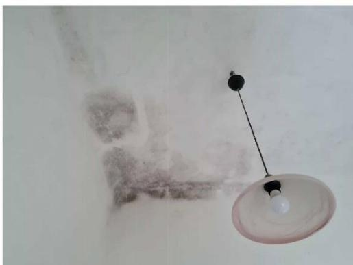
**FOTO 29** - UMIDITÀ, CONDENZA E MUFFA NEI SOFFITTI
