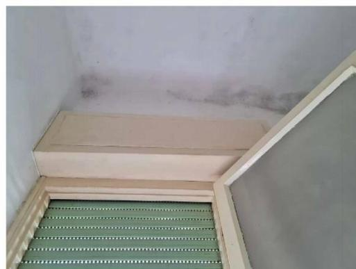
**FOTO 30** - AVVOLGIBILE INFISSO E SOFFITTO CON MACCHIE DI MUFFA
