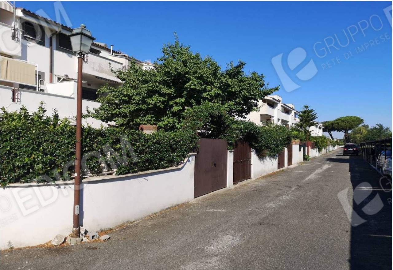
Figg. 3-4 Fabbricato condominiale fronte Via Montepalano – strada semiprivata con area a posteggi privati (di cui l'immobile in oggetto è privo)
