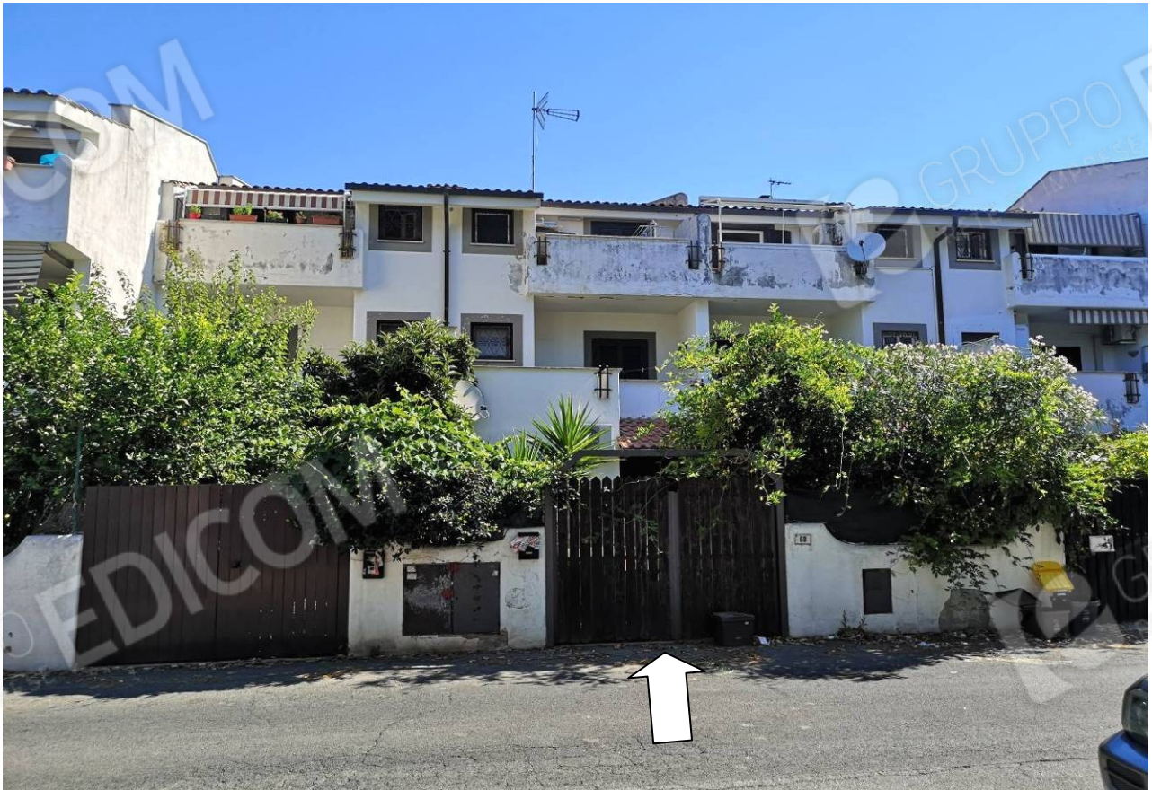
Fig. 37 Via Montepalano civ. 15 – scala E Int. 1 PT sub. 77 – corte/giardino fronte SudOvest lato Via Fregene (civ. 60)
