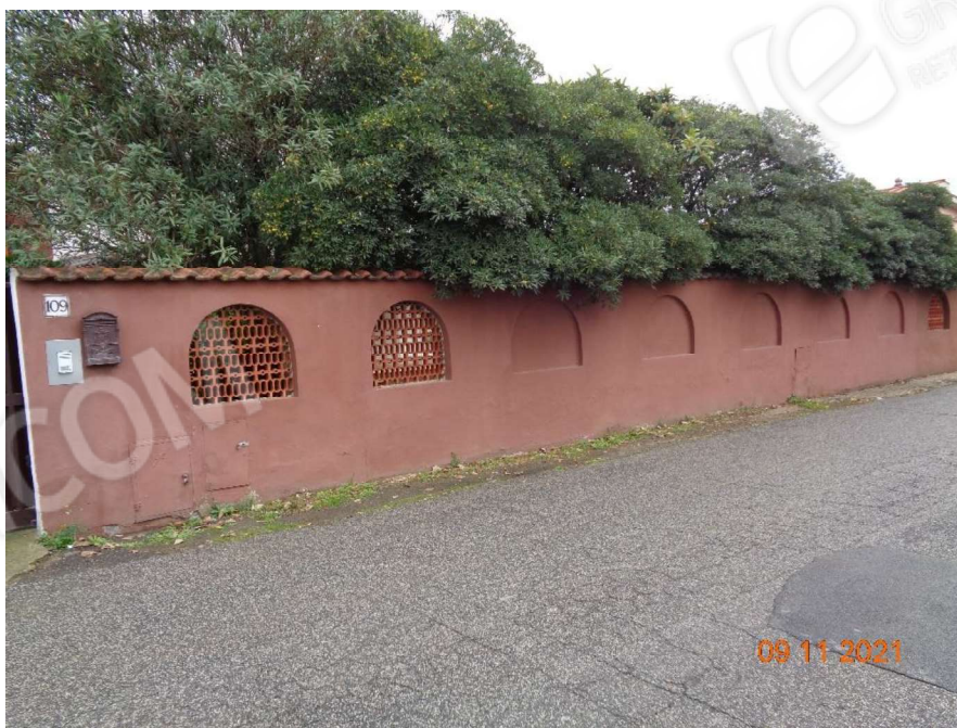
Foto 2 – Vista del muro di cinta lato strada
