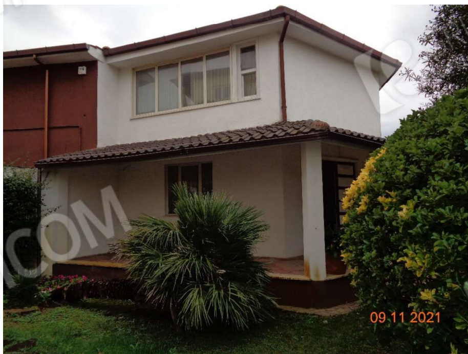
Foto 6 – Vista della facciata nord
