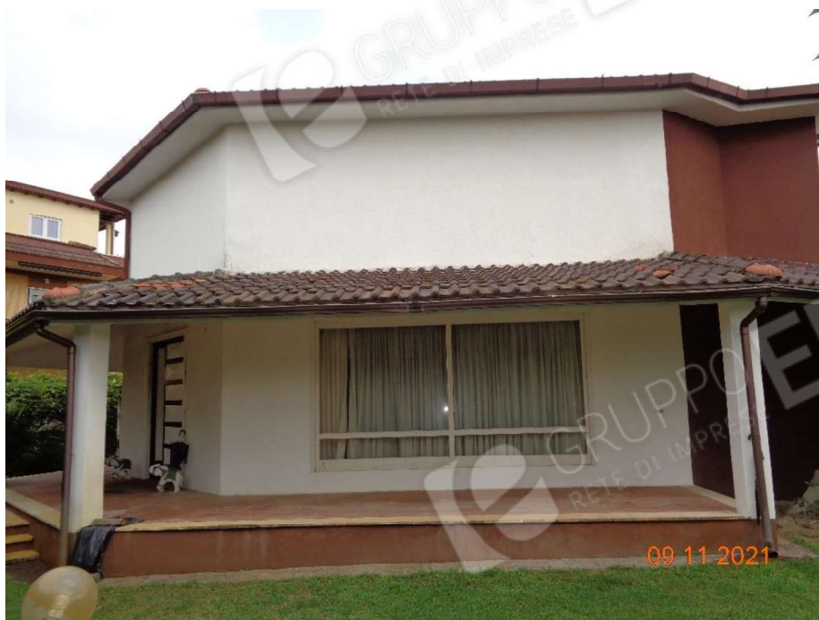
Foto 5 – Vista della facciata ovest
