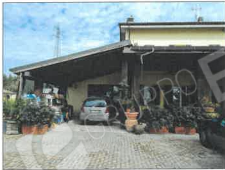
FOTO 26 - VISTA DELLA TETTOIA/PORTICO LATO SUD
