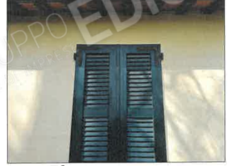
FOTO 78 - DETTAGLIO SCURONE FINESTRA
