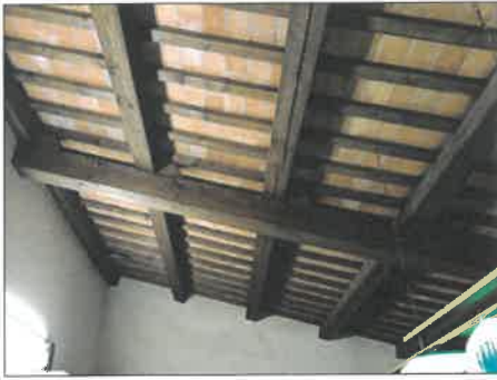
FOTO 85 - COPERTURA IN LEGNO ALI LATERALI FABBRICATO
