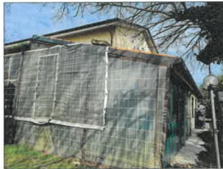
FOTO 20 - PERGOLATO TRASFORMATO A MAGAZZINO
