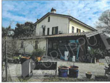
FOTO 14 - VISTA FRONTE LATERALE E PERGOLATO TRASFORMATO A PORTICO
