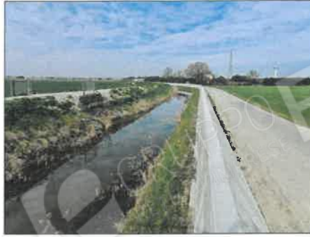
FOTO 02 - VIA BONIFICAZIONE VISTA DELLA STRADA E DEL CANALE
