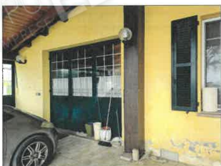
FOTO 22 - PERGOLATO TRASFORMATO A TETTOIA/PORTICO
