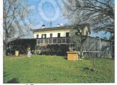
FOTO 15 - PROSPETTO PRINCIPALE LATO SUD E VISTA TETTOIA/PORTICO
