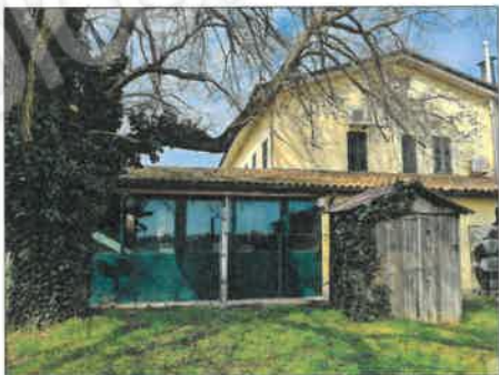
FOTO 19 - PROSPETTO LATERALE E VISTA TETTOIA/PORTICO
