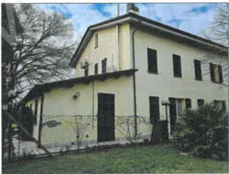
FOTO 16 - PROSPETTO SUL RETRO LATO NORD
