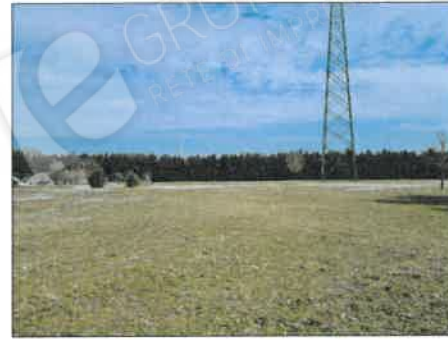
FOTO 57 - VISTA DEL TRALICCIO ALTA TENSIONE E PARCO
