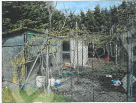
FOTO 50 - CAPANNI E RECINZIONI NON AUTORIZZATE (ANGOLO PARCO)
