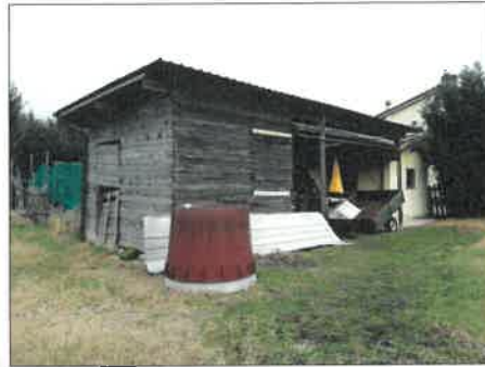
FOTO 44 - MAGAZZINO NON CONFORME INTERNO ALLA CORTE
