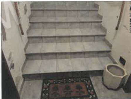
FOTO 88 - SCALA INTERNA DI ACCESSO A PIANO PRIMO
