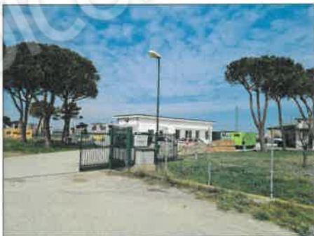
FOTO 07 - CENTRALE DI SOLLEVAMENTO CONSORZIO BONIFICA
