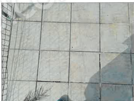
FOTO 67 - DETTAGLIO PAVIMENTO PISCINA
