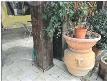
FOTO 79 - COLONNA IN LEGNO PERGOLATO/PORTICO
