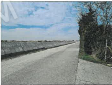
FOTO 04 - MESSA IN SICUREZZA DEL CANALE BONIFICAZIONE
