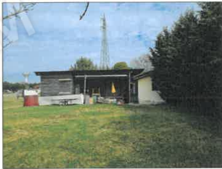
FOTO 40 - MAGAZZINO NON CONFORME INTERNO ALLA CORTE
