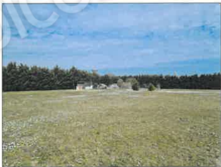
FOTO 55 - CAPANNI NON AUTORIZZATI IN LONTANANZA (PARCO)
