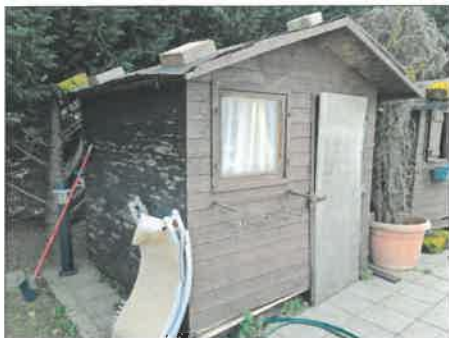
FOTO 61 - CAPANNO NON CONFORME
