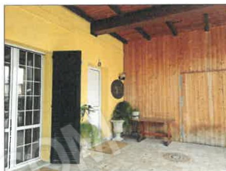
FOTO 23 - PERGOLATO TRASFORMATO A TETTOIA/PORTICO
