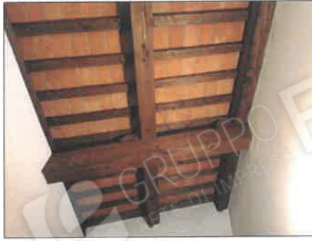
FOTO 86 - COPERTURA IN LEGNO ALI LATERALI FABBRICATO
