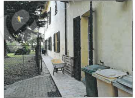
FOTO 21 - PROSPETTO SUL RETRO LATO NORD
