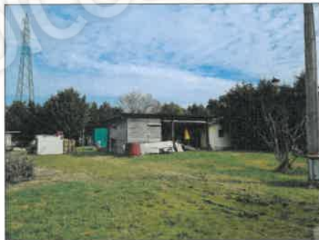
FOTO 43 - MAGAZZINO NON CONFORME INTERNO ALLA CORTE
