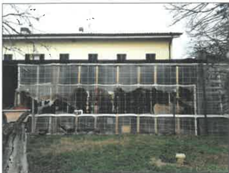
FOTO 25 - PERGOLATO TRASFORMATO A MAGAZZINO
