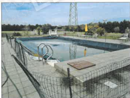
FOTO 58 - PISCINA NON AUTORIZZATA
