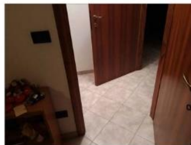
FOTO 92 - PAVIMENTI E PORTE INTERNE
