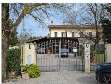
FOTO 11 - CANCELLO D'INGRESSO ALL'ABITAZIONE
