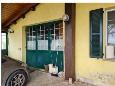
FOTO 22 - PERGOLATO TRASFORMATO A TETTOIA/PORTICO
