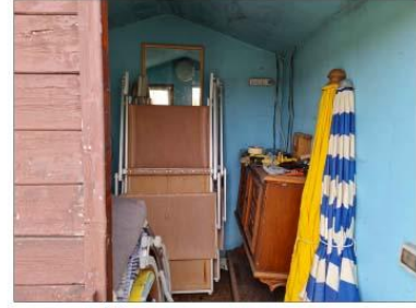
FOTO 63 - MAGAZZINO IN CAPANNO NON AUTORIZZATO
