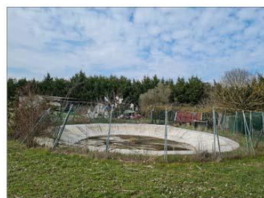
FOTO 51 - VASCA DI RACCOLTA ACQUA PIOVANA (ANGOLO PARCO)
