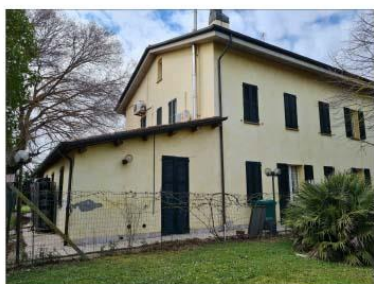
FOTO 16 - PROSPETTO SUL RETRO LATO NORD
