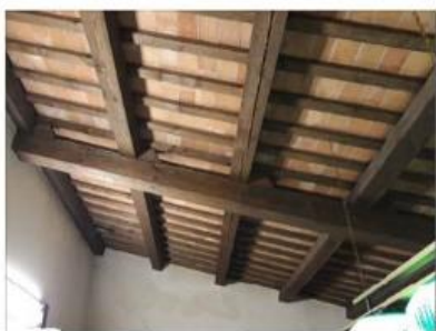
FOTO 85 - COPERTURA IN LEGNO ALI LATERALI FABBRICATO
