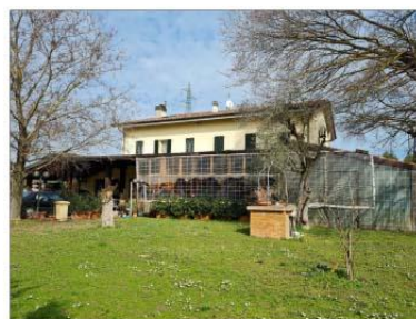
FOTO 15 - PROSPETTO PRINCIPALE LATO SUD E VISTA TETTOIA/PORTICO
