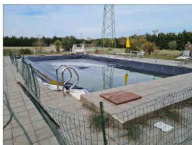
FOTO 58 - PISCINA NON AUTORIZZATA
