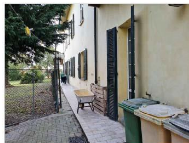
FOTO 21 - PROSPETTO SUL RETRO LATO NORD
