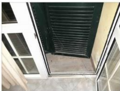
FOTO 91 - INFISSO E SCURI ESTERNI
