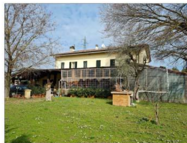
FOTO 15 - PROSPETTO PRINCIPALE LATO SUD E VISTA TETTOIA/PORTICO
