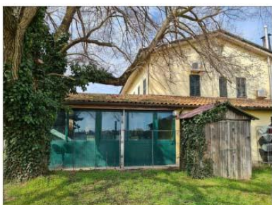
FOTO 19 - PROSPETTO LATERALE E VISTA TETTOIA/PORTICO
