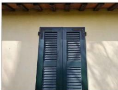
FOTO 78 - DETTAGLIO SCURONE FINESTRA
