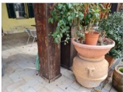
FOTO 79 - COLONNA IN LEGNO PERGOLATO/PORTICO
