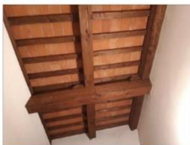
FOTO 86 - COPERTURA IN LEGNO ALI LATERALI FABBRICATO
