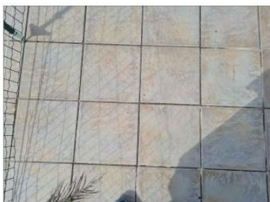
FOTO 67 - DETTAGLIO PAVIMENTO PISCINA
