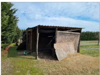
FOTO 46 - CAPANNO NON CONFORME NEL PARCO CIRCOSTANTE
