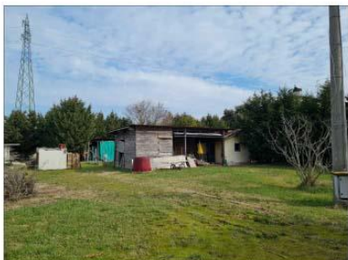
FOTO 43 - MAGAZZINO NON CONFORME INTERNO ALLA CORTE
