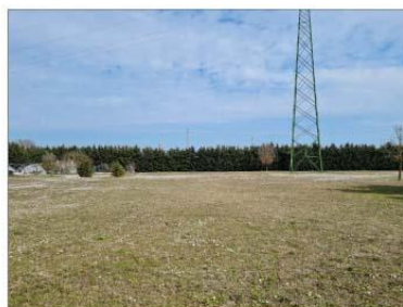
FOTO 57 - VISTA DEL TRALICCIO ALTA TENSIONE E PARCO
