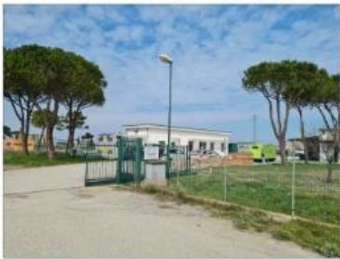
FOTO 07 - CENTRALE DI SOLLEVAMENTO CONSORZIO BONIFICA
