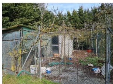
FOTO 50 - CAPANNI E RECINZIONI NON AUTORIZZATE (ANGOLO PARCO)
