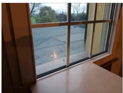
FOTO 94 - TELAIO INFISSO ESTERNO
