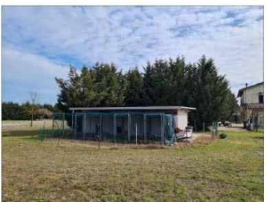
FOTO 41 - BOX CANI NON CONFORME NELL'AREA CIRCOSTANTE OGGI PARCO
