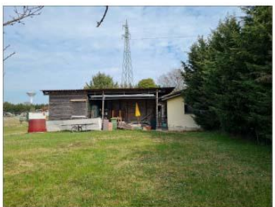
FOTO 40 - MAGAZZINO NON CONFORME INTERNO ALLA CORTE
