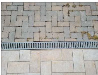
FOTO 83 - DETTAGLIO PAVIMENTO ESTERNO
