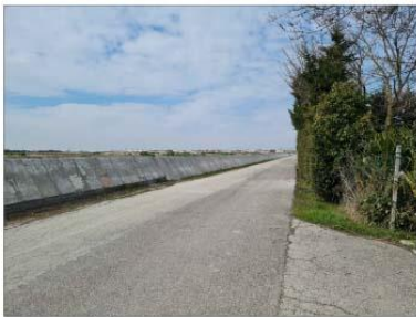
FOTO 04 - MESSA IN SICUREZZA DEL CANALE BONIFICAZIONE
