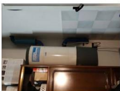
FOTO 139 - ASPIRAZIONE CENTRALIZZATA
