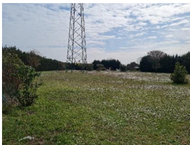
LINEA ALTA TENSIONE ENEL
