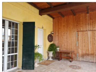
FOTO 23 - PERGOLATO TRASFORMATO A TETTOIA/PORTICO
