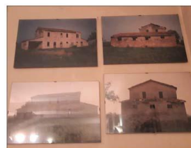
FOTO 144 - EDIFICIO ORIGINARIO EPOCA 1991
