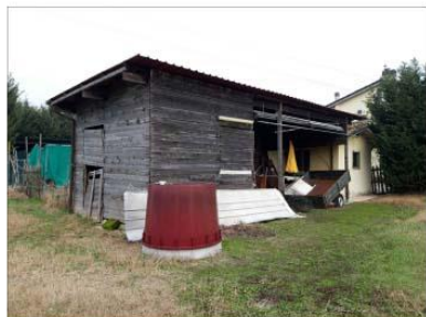
FOTO 44 - MAGAZZINO NON CONFORME INTERNO ALLA CORTE
