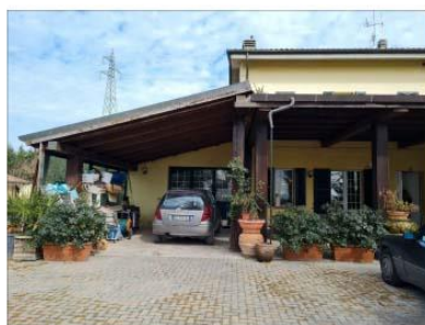
FOTO 26 - VISTA DELLA TETTOIA/PORTICO LATO SUD
