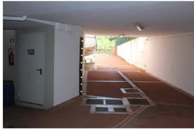
Foto 1.22: rampa di discesa agli stalli vista dall'interno
