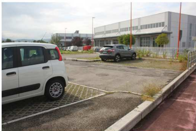
Foto 2.5: parcheggio con accesso da via Rosoleto
