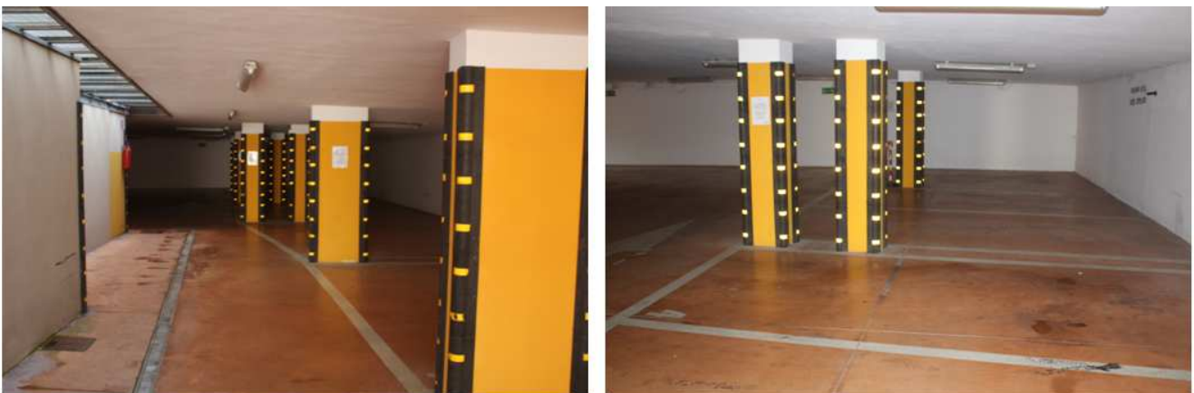
Foto 1.19 – 1.20: vista sulla zona garage
