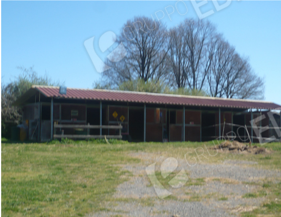
FOTO N. 7 veduta sul manufatto oggetto di demolizione -
