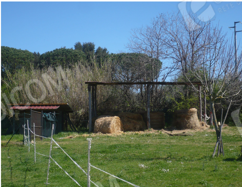
FOTO N. 8 veduta sul fienile oggetto di demolizione -
