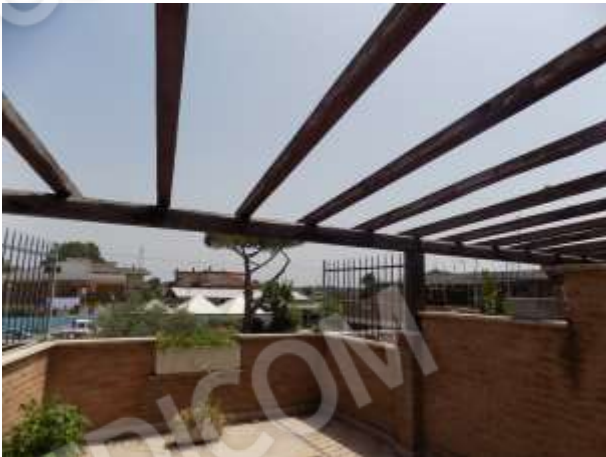
Fig.17-Vista Terrazza P.P. verso corte interna
