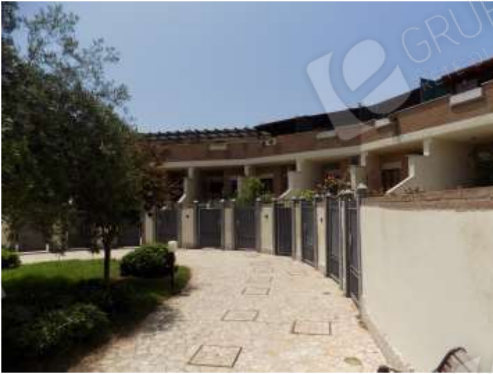
Fig.1-Vista ingresso dalla corte interna
