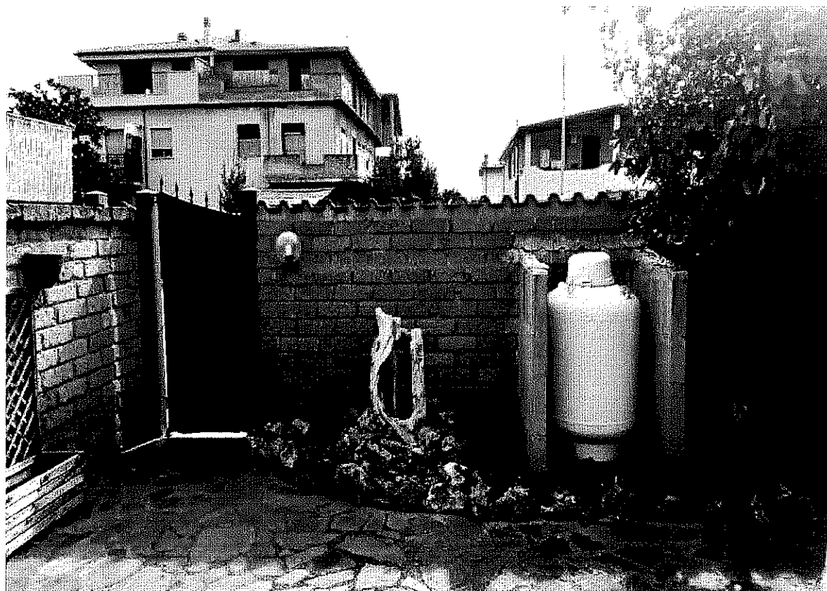
Foto 1: Cancello di entrata e recinzione
